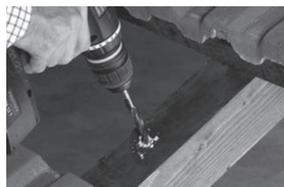
Шаг 2. Сверление отверстия в стропиле
