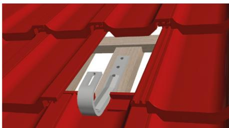
Befestigen Sie nun den Ziegelhaken mit der Unterlage 50 x 150 x 5 mm und zwei Schrauben 5 x 60 mm.
